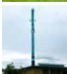
Højby Varmecentral Knullen 28A 5260 Odense S
