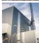
Halmanlægget Havnegade 120 5000 Odense C
