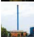
Korup Varmecentral Sandvadvej 1 5210 Odense NV
