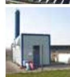
Transportabel 7 Varmecentral Teknikvej 26 5260 Odense S
