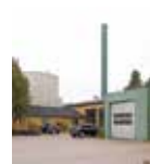
Vissenbjerg Varmeværk Nyvej 9 5492 Vissenbjerg
