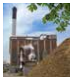
Dalum Kraftvarme Dalumvej 116 5250 Odense SV
