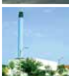
Næsby Varmecentral Højlokke Alle 59 5270 Odense N
