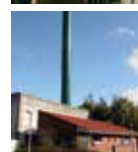
Stige Varmecentral Nistedvej 40 5270 Odense N
