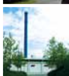
Centrum Varmecentral Enggade 13 5000 Odense C
