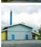
Lumby Varmecentral Slettensvej 351 5270 Odense N
