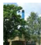
Sanderum Varmecentral Sanderumvej 81 5250 Odense SV
