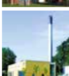
Pårup Varmecentral Havrevænget 2 5210 Odense NV
