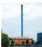
Varmecentral Korup Sandvadvej 1 5210 Odense NV Matr.nr. 8dv Korup By, Trøstrup-Korup Miljøgodkendelse (kategori G102) 22. juli 1982
