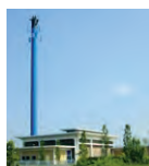
Varmecentral Bellinge Kratholmvej 52 5260 Odense S Matr. nr. 1aø Svenstrup By Stenløse Miljøgodkendelse (kategori G102) 12. februar 1985
