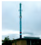
Varmecentral Højby Knullen 28A 5260 Odense S Matr. nr. 12ag, Højby By, Højby Miljøgodkendelse (kategori G102) 20. december 1985
