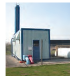
Varmecentral Transportabel 7 Teknikvej 26 5260 Odense S Matr. nr. 17AA Hjallesse by Dalum
