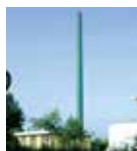
Varmecentral Næsbyhoved Broby Sandgravvej 3 5270 Odense N Matr.nr. 8 k, Næsbyhoved Broby, By Miljøgodkendelse (kategori G102) 27. januar 1992
