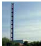
Varmecentral Syd Øst Ørbækvej 418, 5220 Odense SØ Matr. nr. 13 e, Neder Holluf By, Fraugde Miljøgodkendelse 25. oktober 1977. Tilføjelser 27. maj 1982 og 2. januar 1985. Senest godkendelse (kategori G101) 11. oktober 1993
