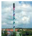
Varmecentral Dyrup Højmevej 15 5250 Odense SV Matr. nr. 8x, Højme By, Sanderum Miljøgodkendelse (kategori G102) 27. december 1978
