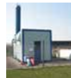
Varmecentral Transportabel 7 Teknikvej 26 5260 Odense S Matr. nr. 17AA Hjallelse by Dalum
