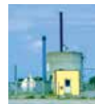
Varmecentral Davinde Udlodsgyden 54 5220 Odense SØ Matr. nr. 4 e Davinde By, Davinde
