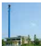
Varmecentral Bellinge Kratholmvej 52 5260 Odense S Matr. nr. 1aø Svenstrup By Stenløse Miljøgodkendelse (kategori G102) 12. februar 1985
