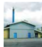
Varmecentral Lumby Slettensvej 351 5270 Odense N Matr. nr. 19 l, Lumby By, Lumby
