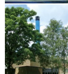
Sanderum Varmecentral Sanderumvej 81 5250 Odense SV
