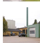
Vissenbjerg Varmeværk Nyvej 9 5492 Vissenbjerg
