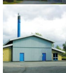
Lumby Varmecentral Slettensvej 351 5270 Odense N
