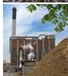
Dalum Kraftvarme Dalumvej 116 5250 Odense SV
