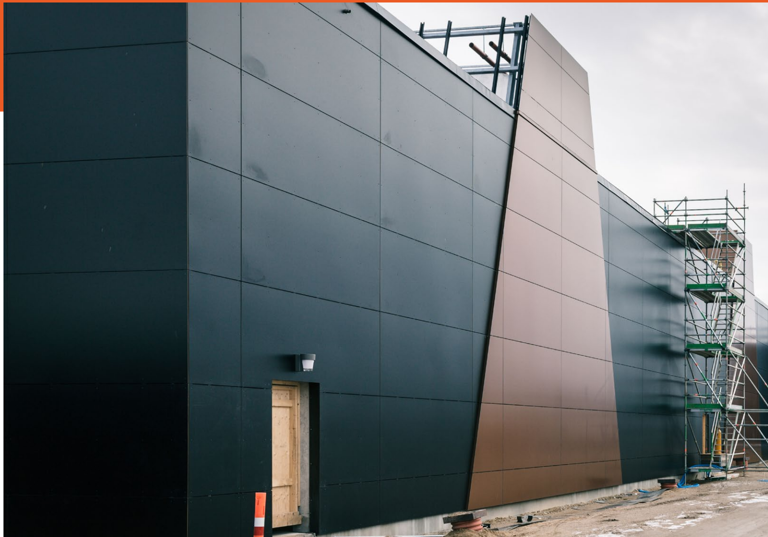
Byggeriet af Tietgenbyens Varmecentral begynder at tage form.
