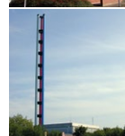
Syd Øst Varmecentral Ørbækvej 418 5220 Odense SØ
