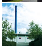
Centrum Varmecentral Enggade 13 5000 Odense C
