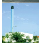
Næsby Varmecentral Højløkke Alle 59 5270 Odense N
