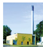
Pårup Varmecentral Havrevænget 2 5210 Odense NV
