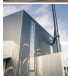
Halmanlægget Havnegade 120 5000 Odense C
