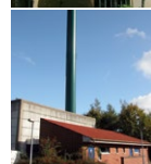
Stige Varmecentral Nistedvej 40 5270 Odense N
