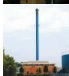
Korup Varmecentral Sandvadvej 1 5210 Odense NV
