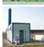
Varmecentral Transportabel 7 Teknikvej 28 5260 Odense S
