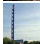
Syd Øst Varmecentral Ørbækvej 418 5220 Odense SØ
