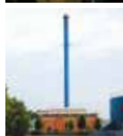
Korup Varmecentral Sandvadvej 1 5210 Odense NV
