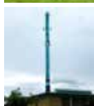
Højby Varmecentral Knullen 28A 5260 Odense S
