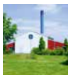
Fangel Varmecentral Borrebyvej 7 5260 Odense S
