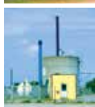
Davinde Varmecentral Udlodsgyden 54 5220 Odense SØ
