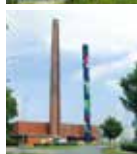
Billedskærervej Varmecentral Billedskærervej 9 5230 Odense M
