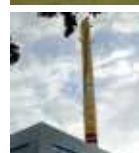
Vollsmose Varmecentral Kildegårdsvej 45 5240 Odense NØ
