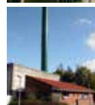
Stige Varmecentral Nistedvej 40 5270 Odense N
