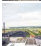
Kulanlægget Havnegade 120 5000 Odense C
