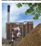
Dalum Kraftvarme Dalumvej 116 5250 Odense SV
