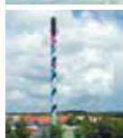
Dyrup Varmecentral Højmevej 15 5250 Odense SV
