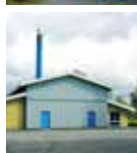
Lumby Varmecentral Slettensvej 351 5270 Odense N
