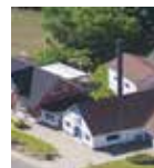
Nr. Broby Varmeværk Stationsvej 14 5672 Broby
