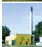
Pårup Varmecentral Havrevænget 2 5210 Odense NV
