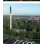
Sygehuset Varmecentral Heden 3 Z 5000 Odense C
