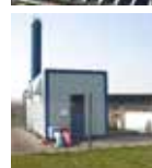
Transportabel 7 Varmecentral Teknikvej 26 5260 Odense S
