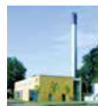
Pårup Varmecentral Havrevænget 2 5210 Odense NV
