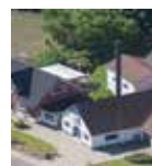
Nr. Broby Varmeværk Stationsvej 14 5672 Broby
