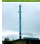
Højby Varmecentral Knullen 28A 5260 Odense S
