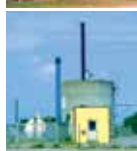
Davinde Varmecentral Udlodsgyden 54 5220 Odense SØ
