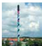
Dyrup Varmecentral Højmevej 15 5250 Odense SV
