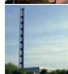
Syd Øst Varmecentral Ørbækvej 418 5220 Odense SØ
