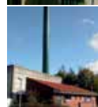
Stige Varmecentral Nistedvej 40 5270 Odense N
