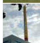
Vollsmose Varmecentral Kildegårdsvej 45 5240 Odense NØ
