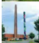
Billedskærervej Varmecentral Billedskærervej 9 5230 Odense M
