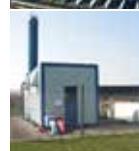
Transportabel 7 Varmecentral Teknikvej 26 5260 Odense S
