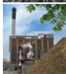
Dalum Kraftvarme Dalumvej 116 5250 Odense SV
