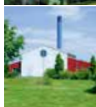
Fangel Varmecentral Borrebyvej 7 5260 Odense S
