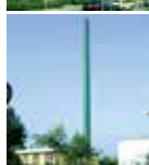
Næsbyhoved Broby Varmecentral Sandgravvej 3 5270 Odense N
