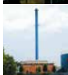
Korup Varmecentral Sandvadvej 1 5210 Odense NV
