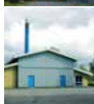
Lumby Varmecentral Slettensvej 351 5270 Odense N
