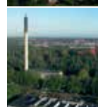
Sygehuset Varmecentral Heden 3 Z 5000 Odense C
