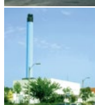
Næsby Varmecentral Højløkke Alle 59 5270 Odense N
