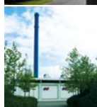
Centrum Varmecentral Enggade 13 5000 Odense C
