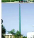
Næsbyhoved Broby Varmecentral Sandgravvej 3 5270 Odense N
