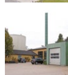
Vissenbjerg Varmeværk Nyvej 9 5492 Vissenbjerg
