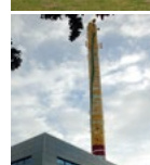
Vollsmose Varmecentral Kildegårdsvej 45 5240 Odense NØ
