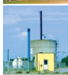
Davinde Varmecentral Udlodsgyden 54 5220 Odense SØ
