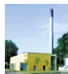
Pårup Varmecentral Havrevænget 2 5210 Odense NV
