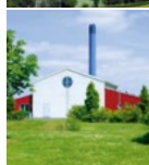
Fangel Varmecentral Borrebyvej 7 5260 Odense S
