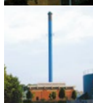
Korup Varmecentral Sandvadvej 1 5210 Odense NV
