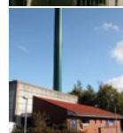
Stige Varmecentral Nistedvej 40 5270 Odense N
