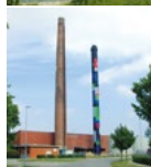
Billedskærervej Varmecentral Billedskærervej 9 5230 Odense M
