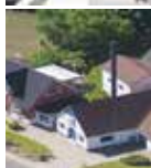
Nr. Broby Varmeværk Stationsvej 14 5672 Broby
