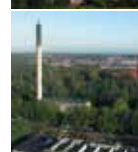
Sygehuset Varmecentral Heden 3 Z 5000 Odense C
