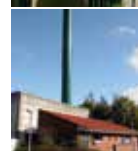
Stige Varmecentral Nistedvej 40 5270 Odense N
