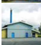
Lumby Varmecentral Slettensvej 351 5270 Odense N
