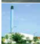
Næsby Varmecentral Højlokke Alle 59 5270 Odense N
