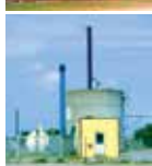
Davinde Varmecentral Udlodsgyden 54 5220 Odense SØ
