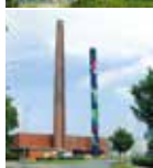
Billedskærervej Varmecentral Billedskærervej 9 5230 Odense M
