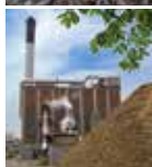
Dalum Kraftvarme Dalumvej 116 5250 Odense SV
