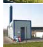
Transportabel 7 Varmecentral Teknikvej 26 5260 Odense S
