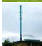
Højby Varmecentral Knullen 28A 5260 Odense S
