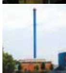
Korup Varmecentral Sandvadvej 1 5210 Odense NV
