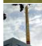
Vollsmose Varmecentral Kildegårdsvej 45 5240 Odense NØ
