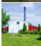
Fangel Varmecentral Borrebyvej 7 5260 Odense S
