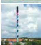
Dyrup Varmecentral Højmevej 15 5250 Odense SV
