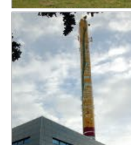
Vollsmose Varmecentral Kildegårdsvej 45 5240 Odense NØ
