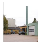
Vissenbjerg Varmeværk Nyvej 9 5492 Vissenbjerg
