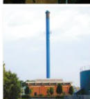
Korup Varmecentral Sandvadvej 1 5210 Odense NV
