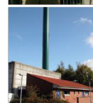
Stige Varmecentral Nistedvej 40 5270 Odense N
