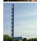
Syd Øst Varmecentral Ørbækvej 418 5220 Odense SØ
