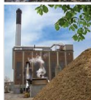
Dalum Kraftvarme Dalumvej 116 5250 Odense SV
