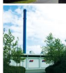
Centrum Varmecentral Enggade 13 5000 Odense C
