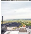
Kulanlægget Havnegade 120 5000 Odense C
