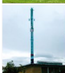
Højby Varmecentral Knullen 28A 5260 Odense S
