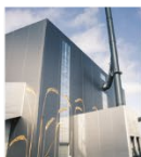
Halmanlægget Havnegade 120 5000 Odense C
