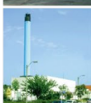
Næsby Varmecentral Højløkke Alle 59 5270 Odense N
