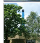
Sanderum Varmecentral Sanderumvej 81 5250 Odense SV
