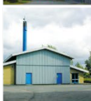
Lumby Varmecentral Slettensvej 351 5270 Odense N
