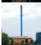
Korup Varmecentral Sandvadvej 1 5210 Odense NV
