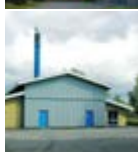
Lumby Varmecentral Slettensvej 351 5270 Odense N
