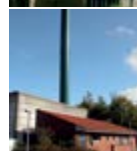
Stige Varmecentral Nistedvej 40 5270 Odense N
