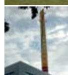
Vollsmose Varmecentral Kildegårdsvej 45 5240 Odense NØ
