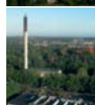
Sygehuset Varmecentral Heden 3 Z 5000 Odense C
