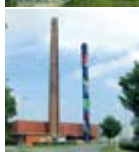
Billedskærervej Varmecentral Billedskærervej 9 5230 Odense M
