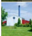
Fangel Varmecentral Borrebyvej 7 5260 Odense S
