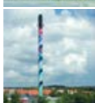
Dyrup Varmecentral Højmevej 15 5250 Odense SV
