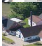
Nr. Broby Varmeværk Stationsvej 14 5672 Broby
