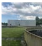
Ejby Mølle Varmecentral Ejbygade 32 5220 Odense SØ
