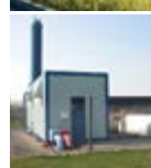
Transportabel 7 Varmecentral Teknikvej 26 5260 Odense S
