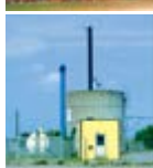
Davinde Varmecentral Udlodsgyden 54 5220 Odense SØ
