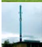
Højby Varmecentral Knullen 28A 5260 Odense S
