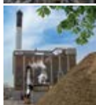
Dalum Kraftvarme Dalumvej 116 5250 Odense SV
