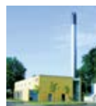
Pårup Varmecentral Havrevænget 2 5210 Odense NV
