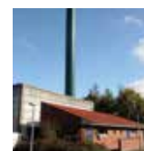
Stige Varmecentral Nistedvej 40 5270 Odense N
