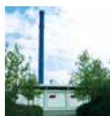
Centrum Varmecentral Enggade 13 5000 Odense C
