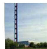
Syd Øst Varmecentral Svovlhatten 11 5220 Odense SØ
