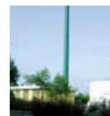
Næsbyhoved Broby Varmecentral Sandgravvej 3 5270 Odense N
