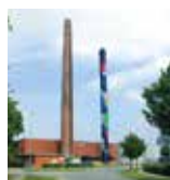
Billedskærervej Varmecentral Billedskærervej 9 5230 Odense M
