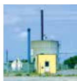
Davinde Varmecentral Udlodsgyden 54 5220 Odense SØ
