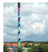
Dyrup Varmecentral Højmevej 15 5250 Odense SV
