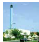
Næsby Varmecentral Højløkke Alle 59 5270 Odense N
