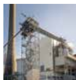
Flisanlægget Havnegade 120 5000 Odense C
