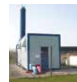
Transportabel 7 Varmecentral Teknikvej 26 5260 Odense S
