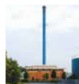
Korup Varmecentral Sandvadvej 1 5210 Odense NV
