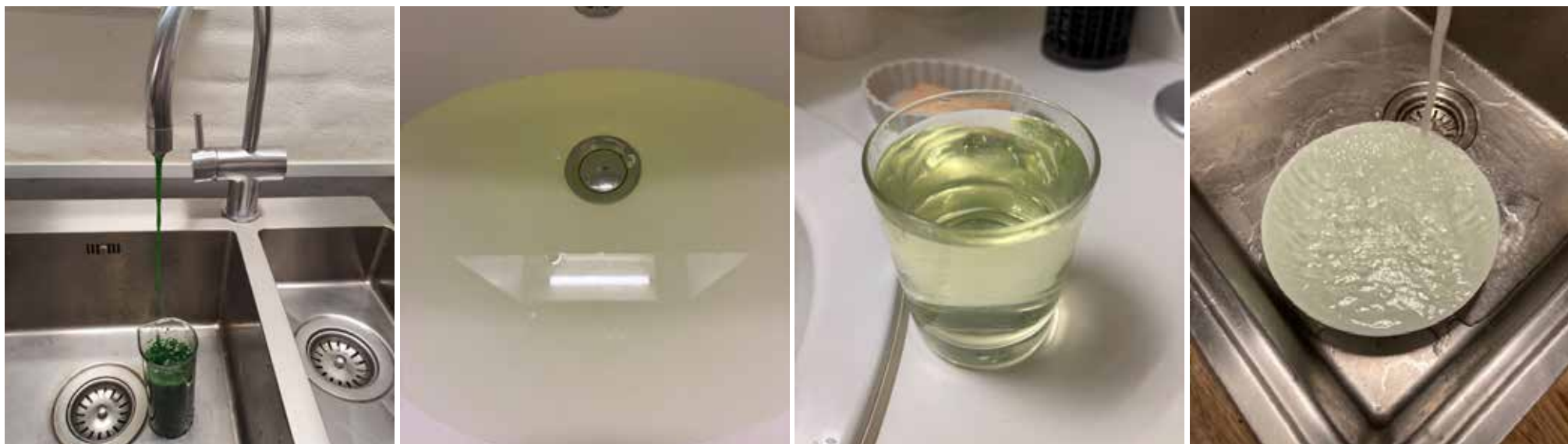
Da Fjernvarme Fyn tilsatte grøn farve til fjernvarmevandet i november 2025, blev kunderne opfordret til at sende fotos. Her ses et udvalg, hvor det er tydeligt, at koncentrationen af den grønne farve varierer afhængigt af størrelsen på utætheden.
