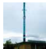
Højby Varmecentral Knullen 28A 5260 Odense S
