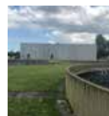
Ejby Mølle Varmecentral Ejbygade 32 5220 Odense SØ
