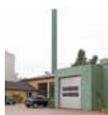
Vissenbjerg Varmeværk Nyvej 9 5492 Vissenbjerg
