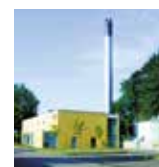
Pårup Varmecentral Havrevænget 2 5210 Odense NV
