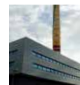
Vollsmose Varmecentral Kildegårdsvej 45 5240 Odense NØ
