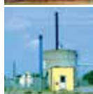
Davinde Varmecentral Udlodsgyden 54 5220 Odense SØ
