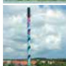
Dyrup Varmecentral Højmevej 15 5250 Odense SV
