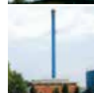
Korup Varmecentral Sandvadvej 1 5210 Odense NV
