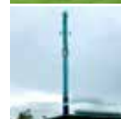
Højby Varmecentral Knullen 28A 5260 Odense S
