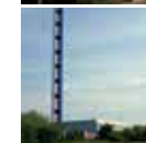
Syd Øst Varmecentral Svovlhatten 11 5220 Odense SØ
