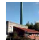
Stige Varmecentral Nistedvej 40 5270 Odense N
