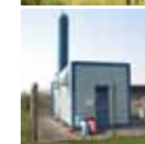
Transportabel 7 Varmecentral Teknikvej 26 5260 Odense S
