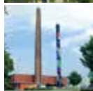
Billedskærervej Varmecentral Billedskærervej 9 5230 Odense M
