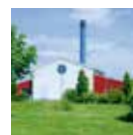
Fangel Varmecentral Borrebyvej 7 5260 Odense S
