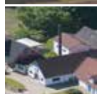
Nr. Broby Varmeværk Stationsvej 14 5672 Broby
