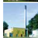
Pårup Varmecentral Havrevænget 2 5210 Odense NV
