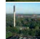
Sygehuset Varmecentral Heden 3 Z 5000 Odense C
